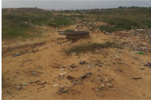
Des sillons d'érosion sur un casier fermé
