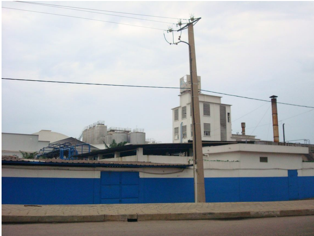
Photo : N° 15 Bâtiment de la SOBEBRA à Akpakpa
