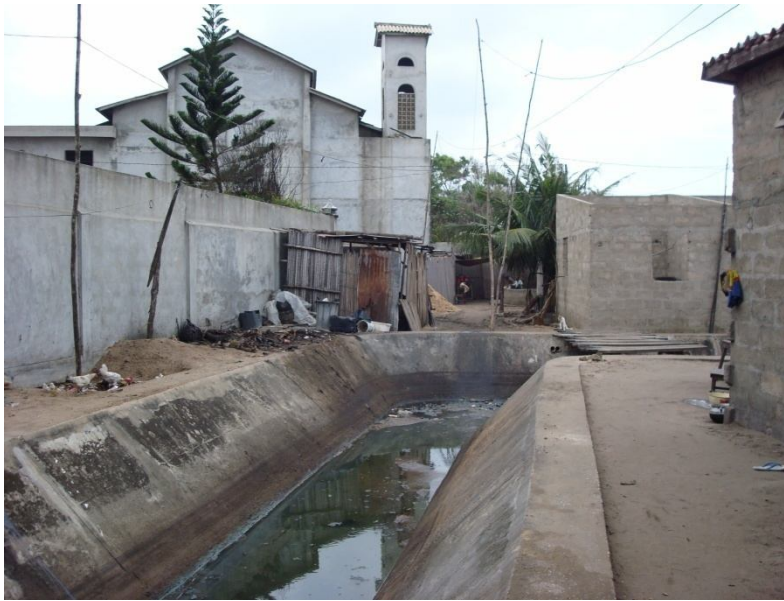
Photo : N°8 Collecteur construit au quartier Donatin
