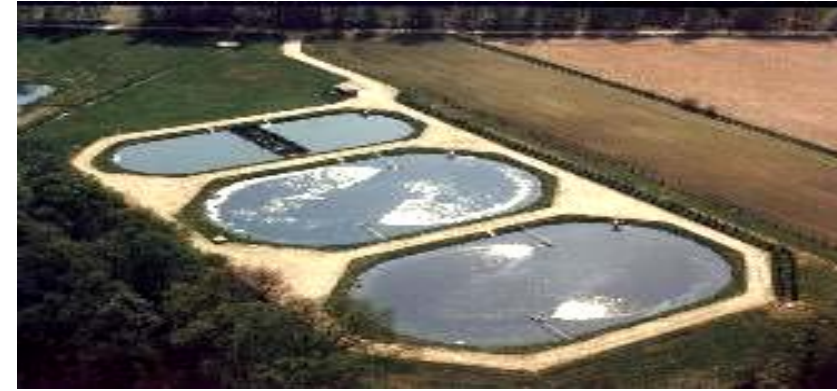
A droite : Vue partielle d'une lagune aérée (500 EH)
