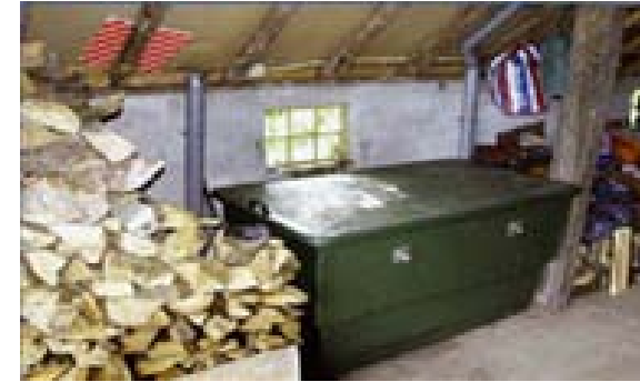
A gauche : Implantation d'un procédé Biorock hors-sol (dans un garage)
