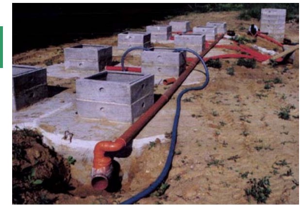
A droite : Station Biofrance de 500 EH en cours d'implantation
