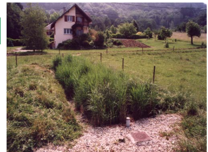
A gauche : Implantation d'un lit planté de roseaux individuel
