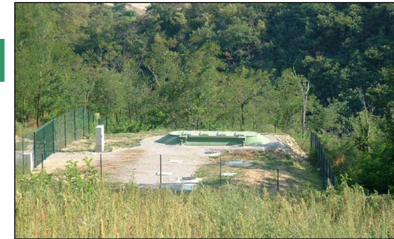
A droite : Station d'épuration Bioclere pour un hameau en montagne de 300 EH
