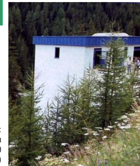
A droite : Station d'épuration en montagne : Spiss (650 EH)
