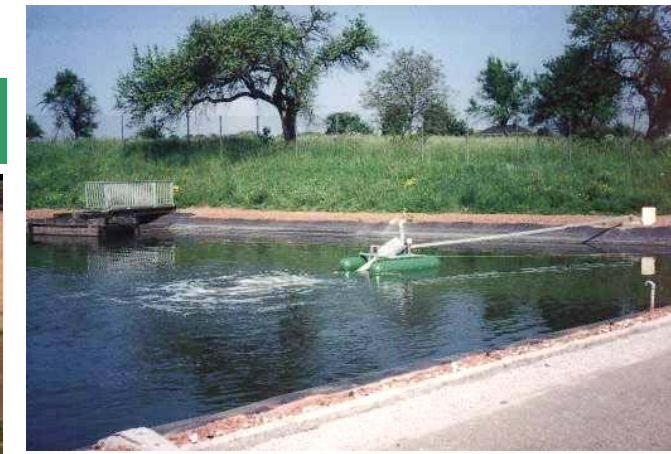
A droite : Vue partielle d'une lagune aérée (500 EH)
