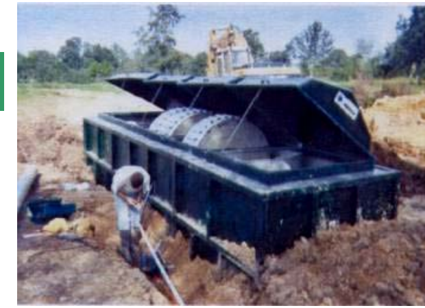
A droite : Station type Shannon en cours d'installation
