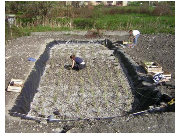
A gauche : Implantation d'un lit planté de roseaux individuel
