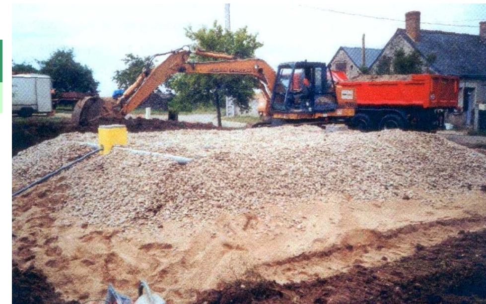
Implantation d'un tertre d'infiltration (assainissement autonome)
