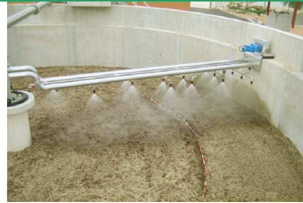
A gauche : Arrivée des eaux usées par un asperseur rotatif au dessus du lombrifiltre (avant la mise en eau)
