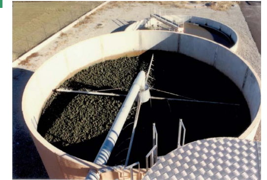
A droite : Technique d'aspersion par sprinklers rotatifs
